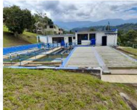
Dentro de las actividades de mantenimiento de las estructuras de la Planta de Tratamiento de Agua Potable PTAP se tiene la limpieza de floculadores, posteriormente la remoción de materiales sólidos suspendidos en los desarenadores, limpieza de los filtros y demás estructuras de la planta que presenten alteraciones por la acumulación de sólidos presentes en el agua.
