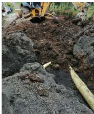
1. Excavación para tubería 10"
