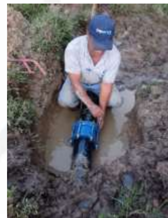
Instalación Unión agarra de Tigre de 6" y 8" pulgadas
