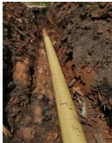
2. Instalación nueva tubería de 10"
