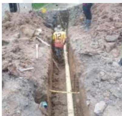
3. Excavación e instalación tubería de 6"
