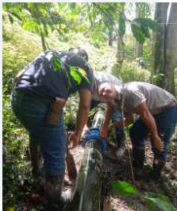
Instalación Unión agarra de Tigre de 6" y 8" pulgadas
