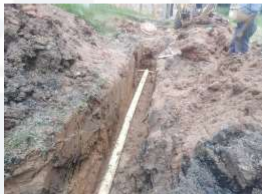
3. Excavación e instalación tubería de 6"
